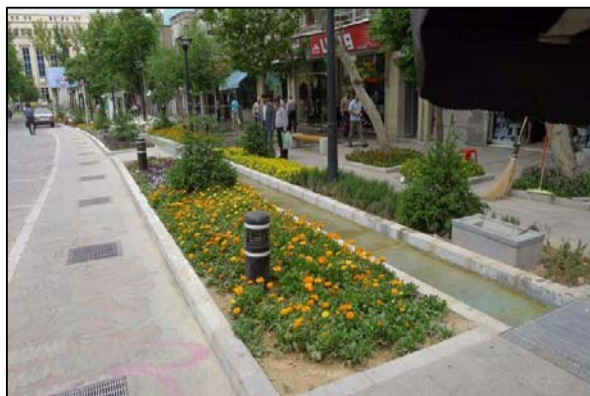
خیابان باب همایون پس از اجرای طرح
