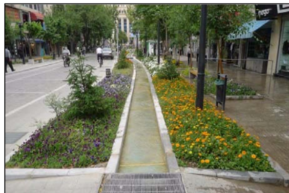
خیابان باب همایون پس از اجرای طرح
