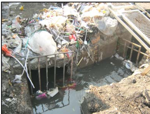
وضع موجود دفع آب های سطحی قبل از اجرای طرح
