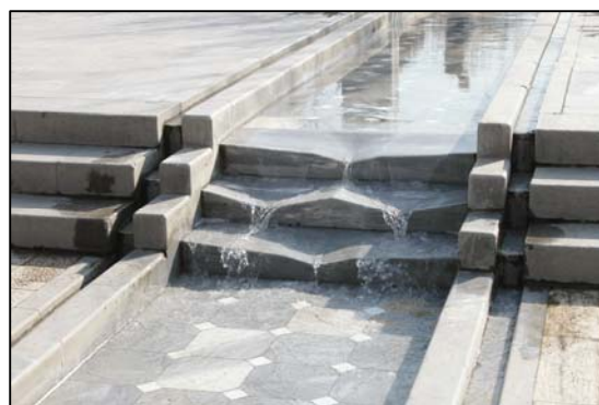
جویبار ورودی از باغ فرهنگی به باغ پذیرایی و آب‌نمای ادامه این مسیرها که در نهایت به استخر قدیمی می‌ریزد. برای جلوگیری از ورود آب‌های ناشی از شستشوی کف، دو جوی کوچک مجزا در دو طرف مسیر آب پیش‌بینی شده است.
