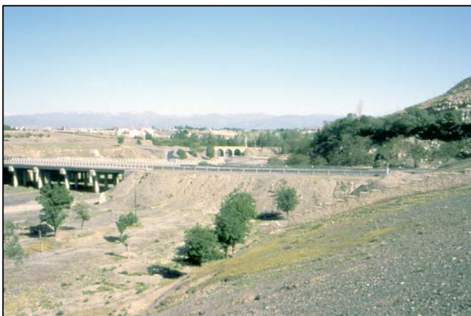
منظره ای از کاسه پرتوی، پل آجری و پل پرتوی قبل از اجرای قطار شهری
