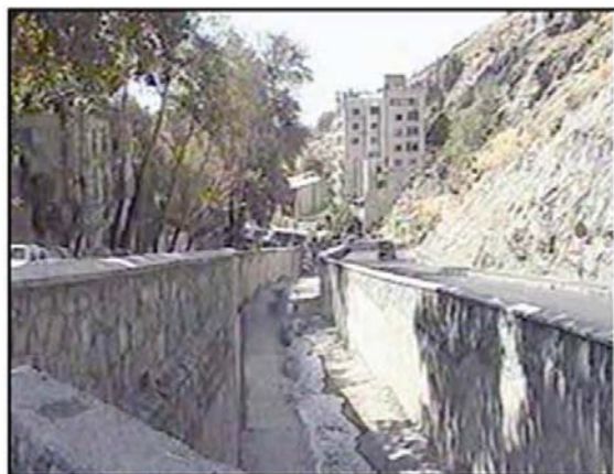
تغییر ماهیت رودخانه دربند به یک کانال بتنی با مسیر سواره در دو طرف
