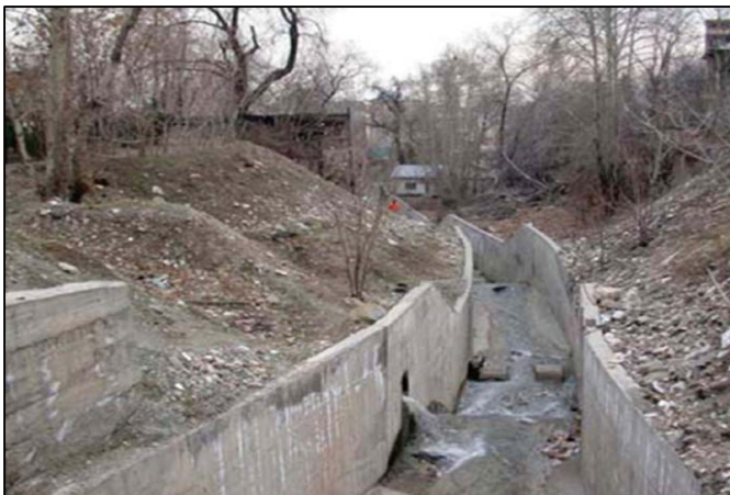
مسیر گل‌آبدرد بعد از اجراء کانال بتنی
