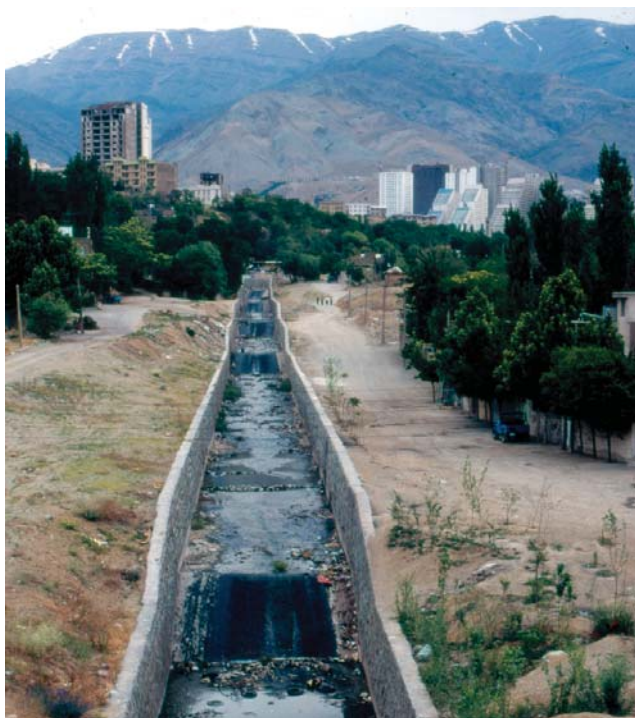
رود- دره اوین- درکه- تهران ساخت دیوارهای بتنی در بستر رودخانه‌ها و تبدیل تدریجی آن به کانال فاضلاب شهر. نشانه‌ای از بی‌توجهی به ارزش رود- دره‌های شهری است.
