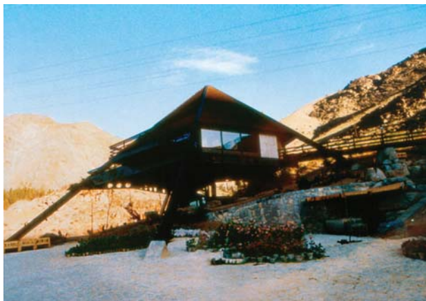
همان محل پس از اجرای طرح
