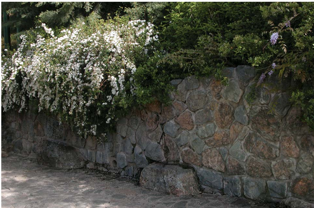
دیوار حافظ خاک در ضلع شمالی راه اضطراری با گیاهان گل‌سین و اسپیره
