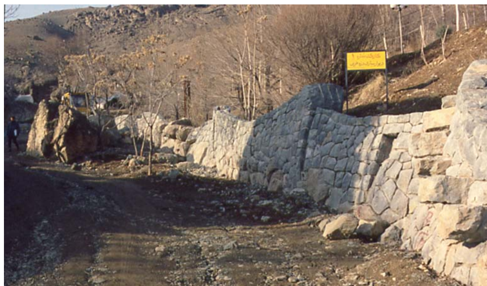
دیوار محل دیوار فوق در ضمن اجرای طرح
