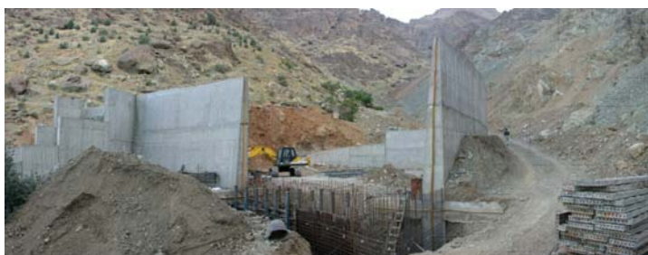
عملیات سنگ‌برداری برای احداث سیل‌گیر
