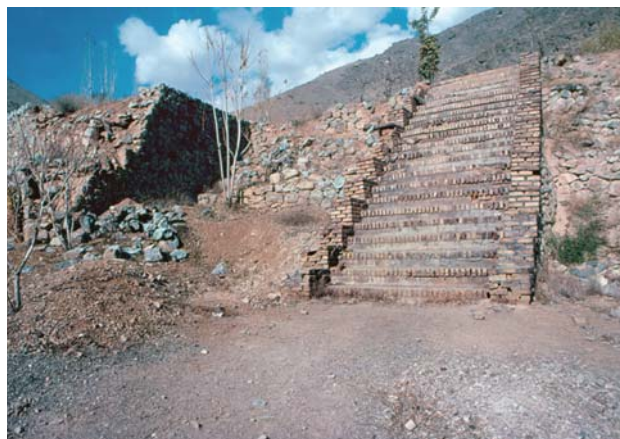
وضعیت اختلاف سطح استخر با سطح زیر آن قبل از اجرا
