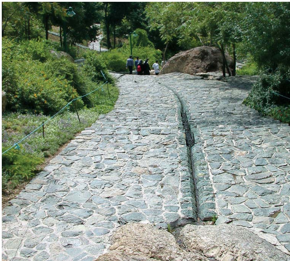
خطوط بخشی از راه ورودی قبل از میدان آذربایجان
