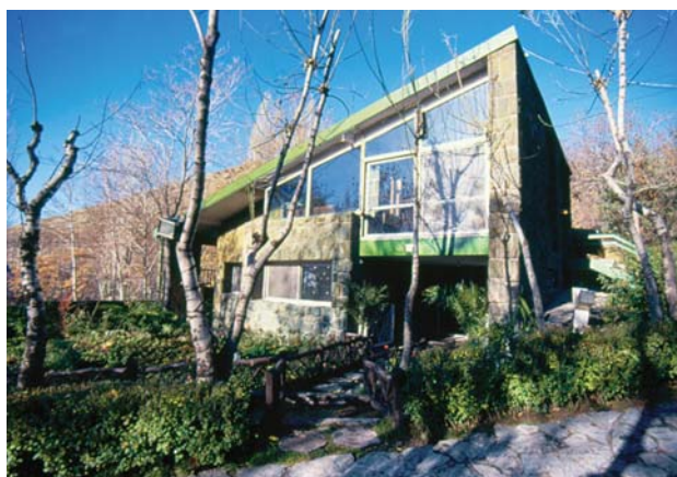
ساختمان اداری و استراحت باغبانان
