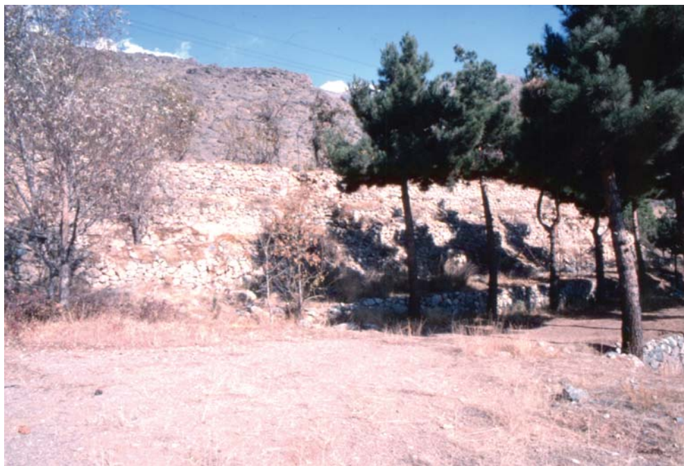
دیوار آجری مخروبه حافظ خاک قبل از احداث دیوار سنگی
