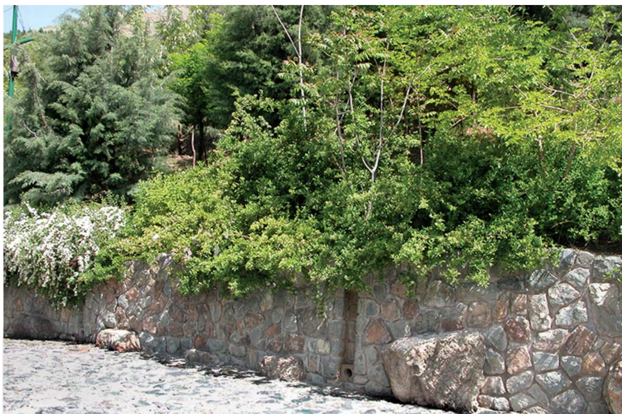
دیوار دیوار حافظ خاک در شمال راه اضطراری
