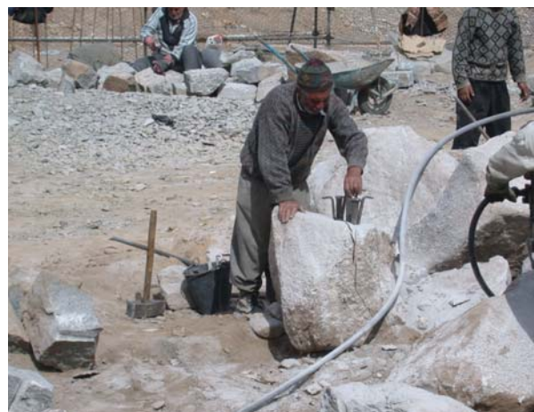
خرد کردن سنگ‌های بزرگ در محل بدون مواد منفجره با استفاده از نعل پارس
