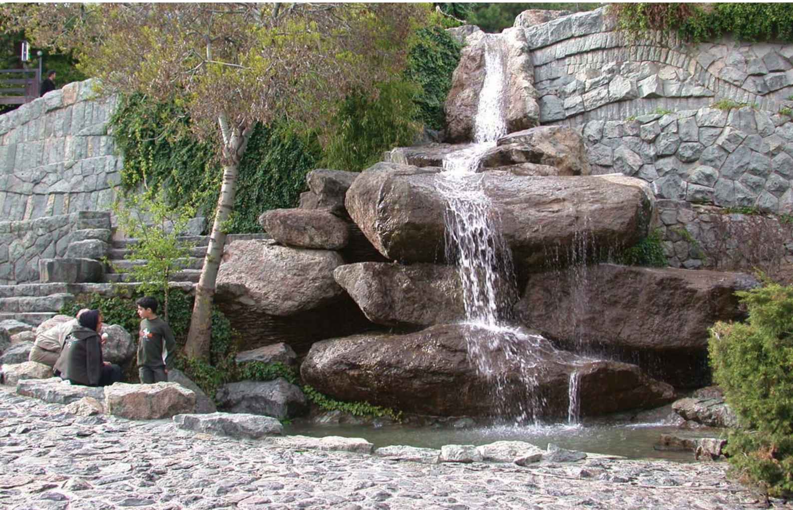
دیوار سنگی حافظ خاک در شمال باغ همراه با سنگ‌های بزرگ کشانده شده از ارتفاعات فرادست
