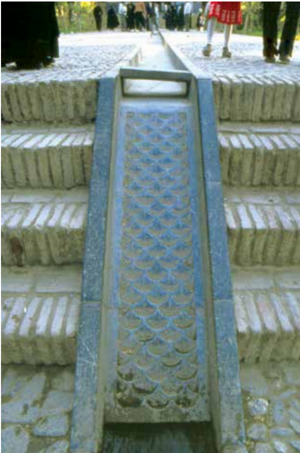
باغ قدمگاه- نیشابور: اجرای فرم پولک ماهی (سینه‌گفتی) در کف جوی برای ایجاد تالو آب
