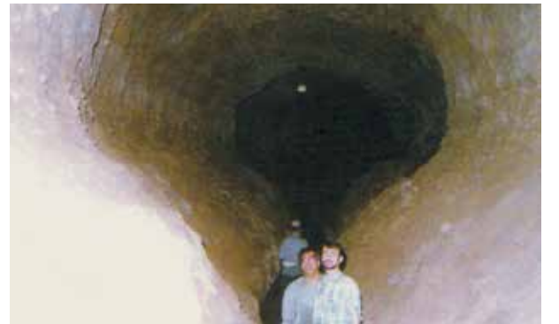
قنات قصبه- گناباد: یکی از مسیرهای اصلی جمع‌آوری آب- به حجم مسیر و مقطع ویژه آن توجه شود. این نمونه‌ای از قنات‌های متعدد در شهرهای حاشیه کویر مرکزی ایران است. ۱
