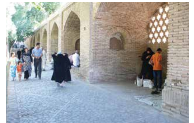
باغ قدمگاه- نیشابور: دیوار حفاظ خارجی با ضخامت زیادتر احداث شده و برای استفاده از فضای تلف شده محل اطراف بازدیدکنندگان در آن تعبیه شده است.
