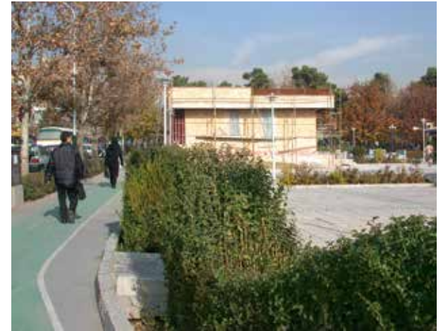
پارک لاله- تهران: در حالی که منظر سبز پارک همواره آرامش‌بخش معابر پیرامونی است، احداث سرویس بهداشتی عمومی، با حجم بزرگ در کنار خیابان اصلی، آلوده کردن منظر شهری است. این ساختمان می‌توانست با طرح مناسب در داخل زمین قرار گیرد.
