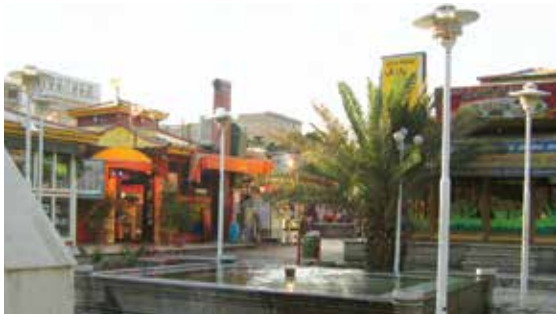
پارک لاله - تهران: فروشگاه‌های متعدد در ورودی اصلی پارک، محوطه ورودی و ارتباط پارک را مخدوش و فضای شهری تقاطع دو خیابان مجاور را نابسامان نموده است.
