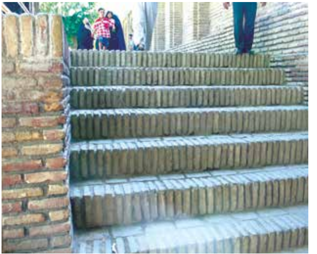
باغ قدمگاه - نیشابور: دیوارهای اصلی حائل اختلاف سطح (تصویر پله‌های آجری باغ قدمگاه)
