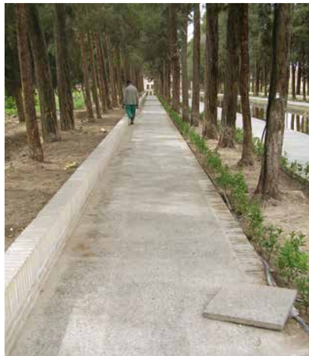
باغ دولت‌آباد - یزد: پس از تعمیرات دیوارها و جدول جداکننده باغچه‌ها از آجر بزرگ
