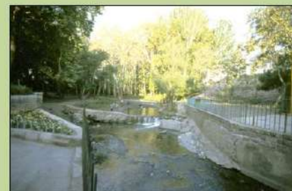
منظره دیواره رودخانه قبل از طراحی جدید
