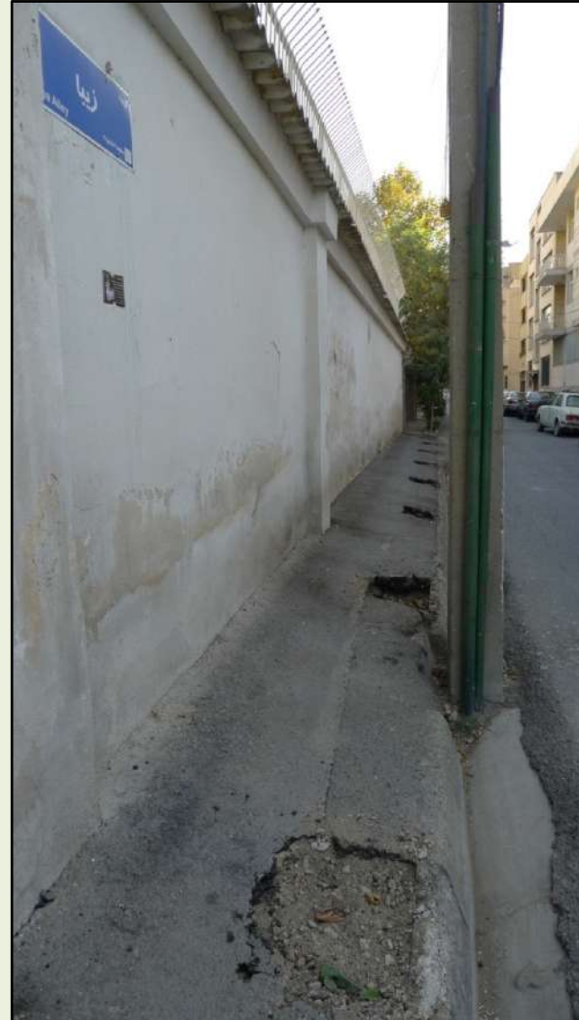
حفر چاله برای درخت
