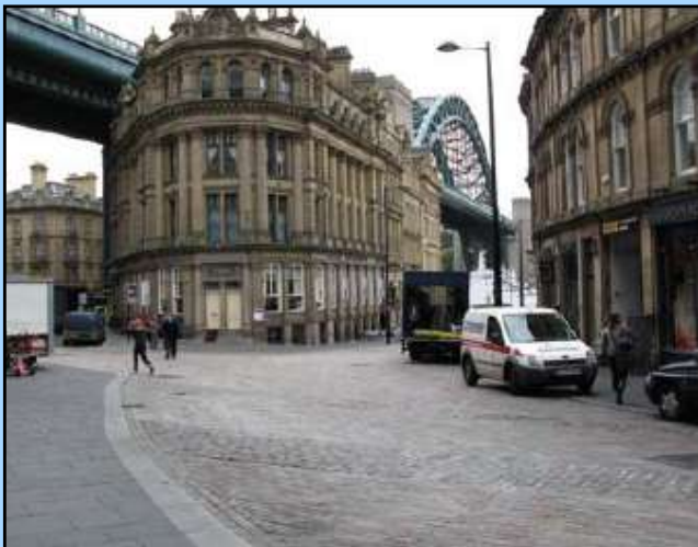
نیوکسل- انگلستان: کاربرد سنگ مکعب مستطیل در مسیر اتومبیل و سنگ پلاک در مسیر پیاده
