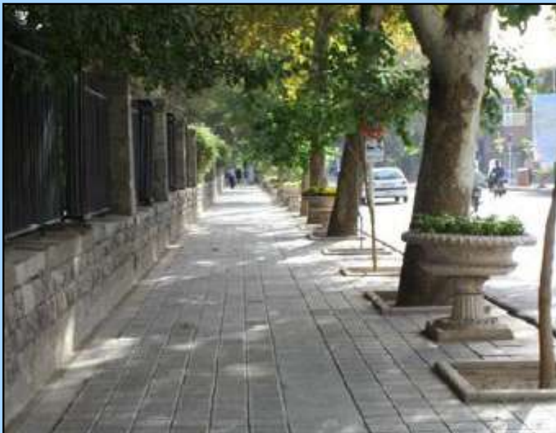
تهران- خیابان بهشت: فرش سنگی کف- با نقش ناشی از پخی چهار لبه سنگ ها
