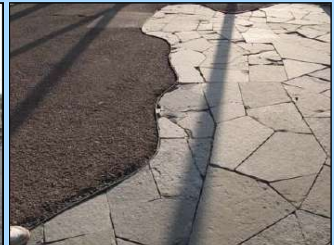
نیوکسل- انگلستان: کاربرد سنگ پلاک فرم آزاد- گوشه های تیز فاقد مقاومت کافی هستند و زودتر آسیب دیده اند
