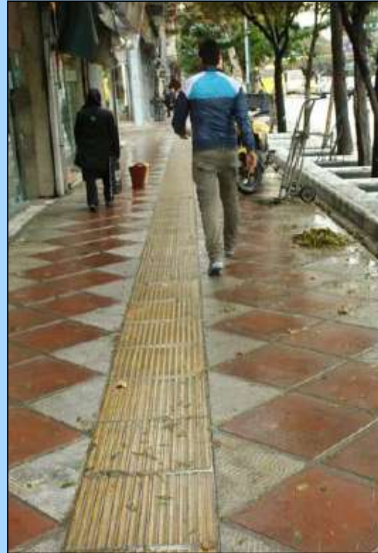
تهران- خیابان فردوسی: فرش سنگی کف با نقش ناشی از زوایای لبه تیز سنگ
