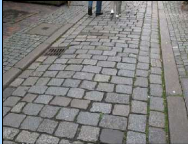
کوردوبا- اسپانیا: کاربرد سنگ مکعب (مسطح) با ابعاد کوچک برای پیاده رو ها. جداول سنگی جداکننده و سنگ قطعات بزرگتر برای مسیر اتومبیل
