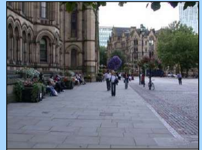
منچستر- انگلستان: میدان شهرداری- سنگ مکعب با ملات در مسیر اتومبیل- سنگ پلاک با ملات در مسیر پیاده
