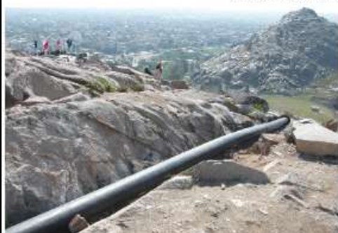
عبور لوله‌های آب (از جنس پلی اتیلن) از لایه‌ای شکاف‌های موجود بین صخره‌ها
