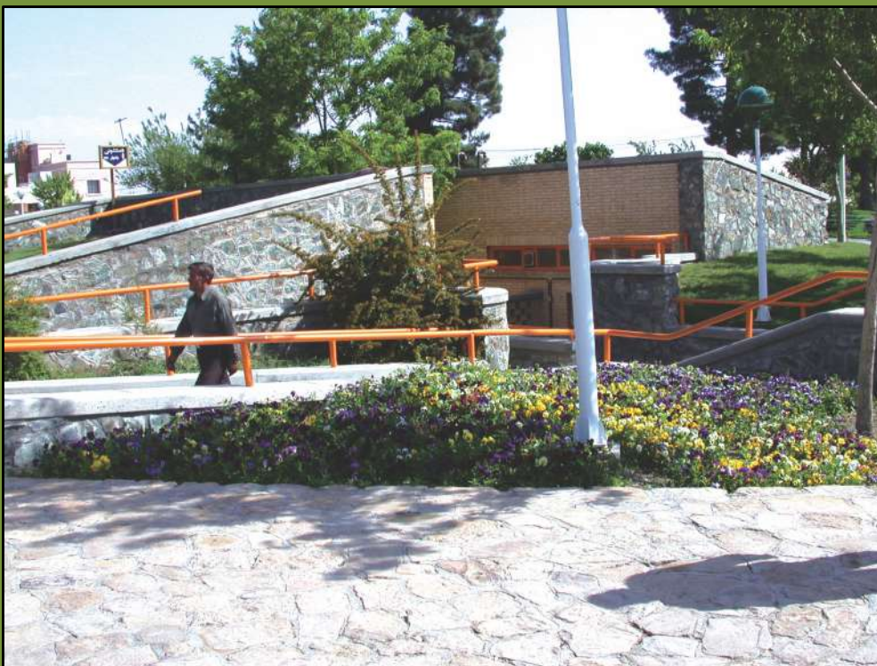
مجتمع کوهسنگی مشهد- بنای خدماتی (دستشویی) با سقف سبز
